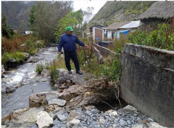
Foto 03.- Se observa el colapso de la bocanoma y canal de riego por las crecidas de sus aguas.
